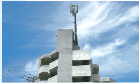
携帯電話基地局指向性アンテナ（壁付タイプ）【石川県金沢市】
