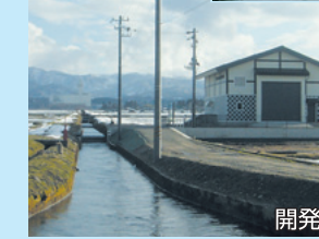
仁右工門発電所
