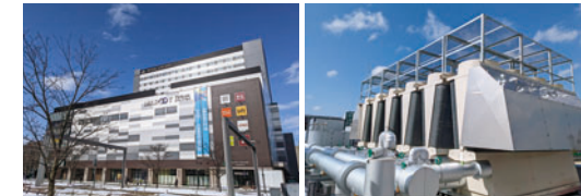
MAROOT 外観 空調設備 (ヒートポンプチャラー)
