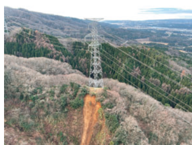
275kV 鉄塔周辺地山表層崩れ
