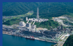
敦賀火力発電所1号機
