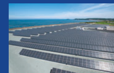
三国太陽光発電所
