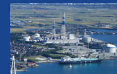
富山新港火力発電所LNG1号機
