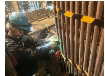
七尾大田火力発電所 ボイラー補修作業の様子
