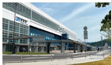
無電柱化した北陸新幹線敦賀駅前
