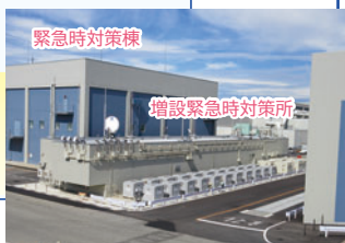
緊急時対策棟・増設緊急時対策所
