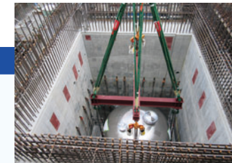
格納容器フィルタ付バント装置
