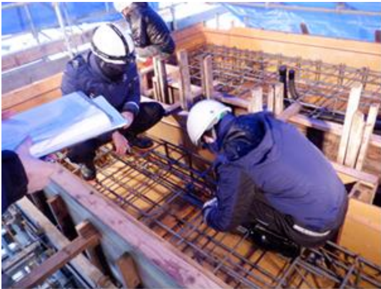
写4-1 打設前 (鉄筋検査)
