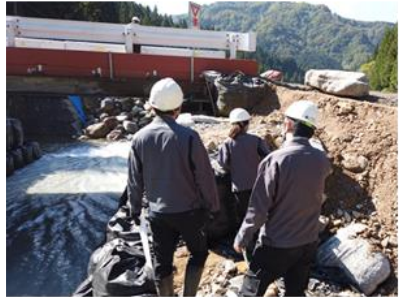
写4-13 仮設橋梁の状況確認
