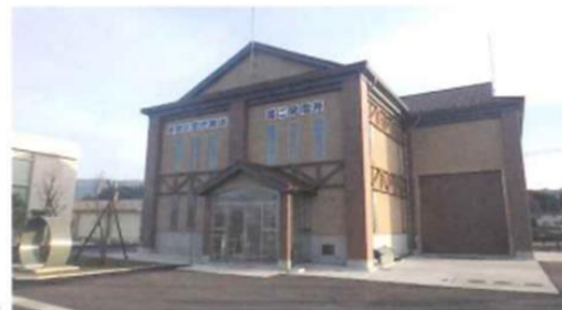
宮竹用水第二発電所 手取川宮竹用水土地改良区
