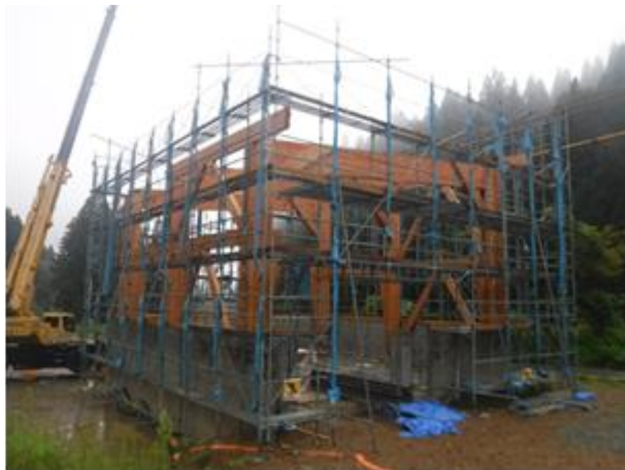
写2-6 建て方状況
