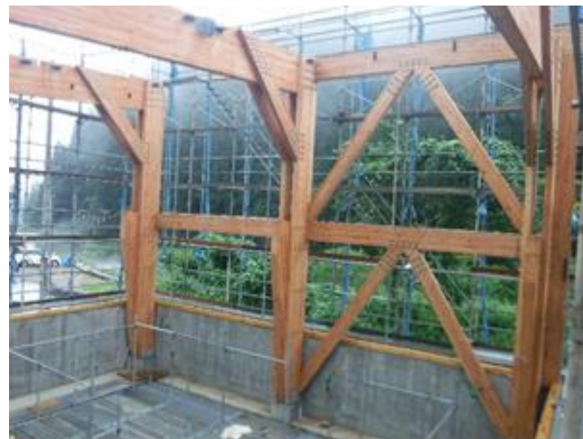
写2-7 建て方状況 (内面)
