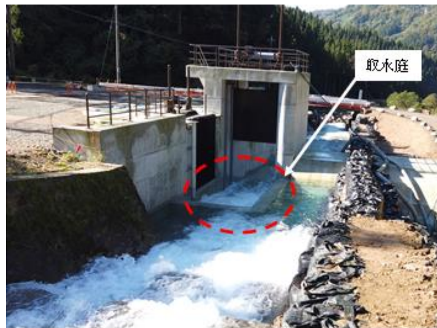
写2-3 取水庭 (上流より)
