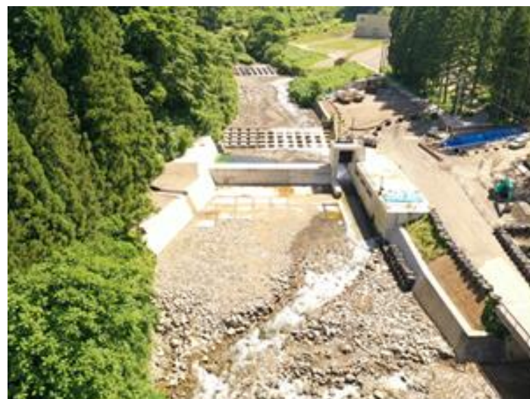
写5-3 別又谷取水設備の完成状況
