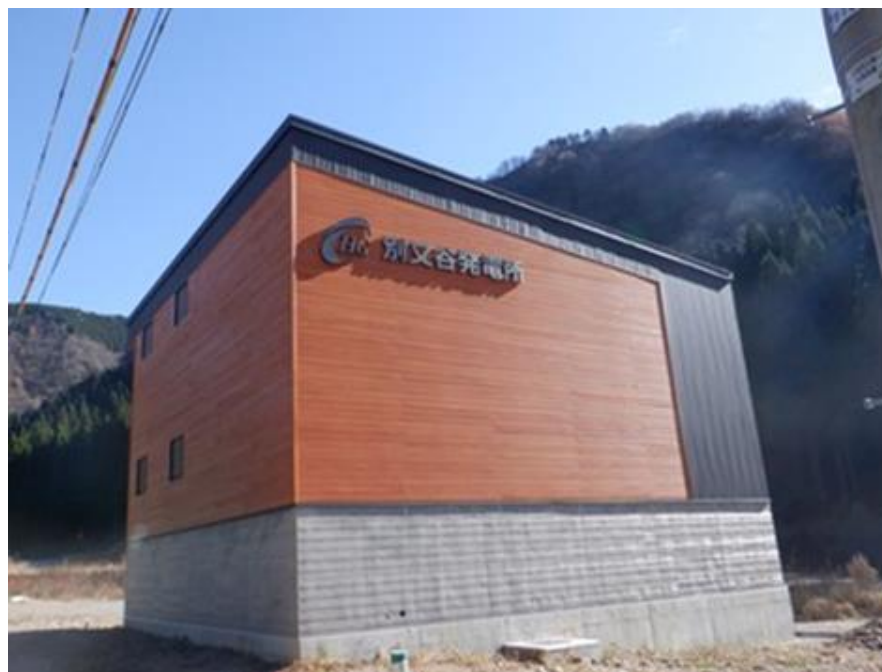
写2-12 外観（下流側）
