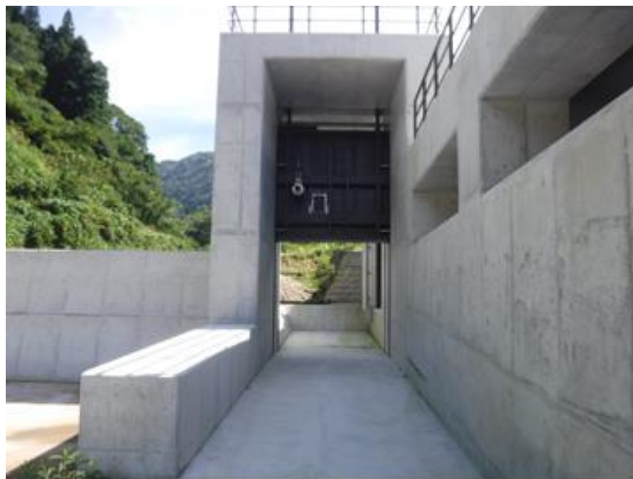
写2-4 取水庭 (下流より)
