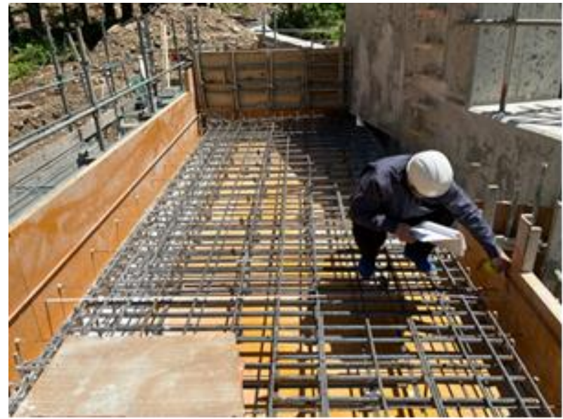
写4-2 打設前 (型枠検査)
