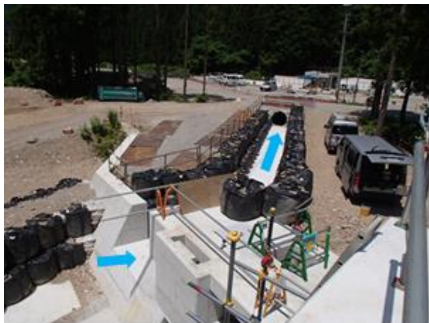
写2-14 仮排水路（一ノ又谷より）
