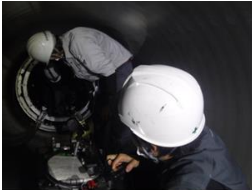
写4-11 水圧管路（水密試験立会）
