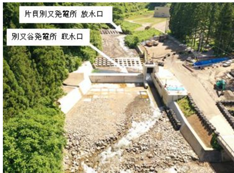
写2-1 別又谷発電所上流の状況
