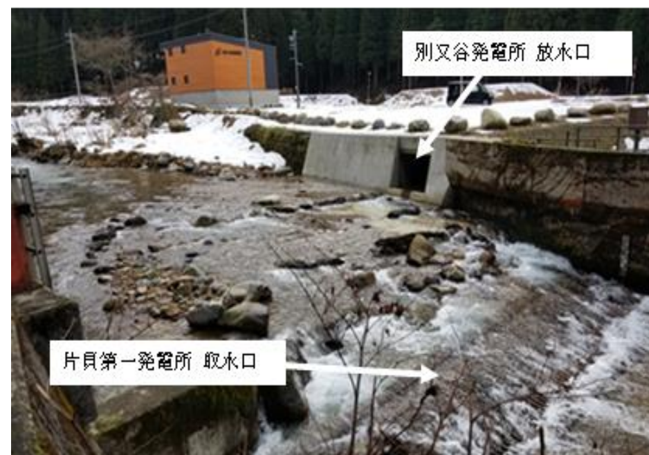
写2-2 別又谷発電所下流の状況
