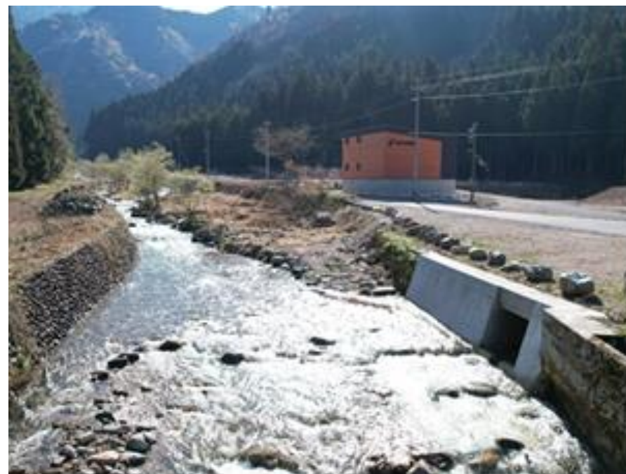
写5-1 発電所・放水口の完成状況
