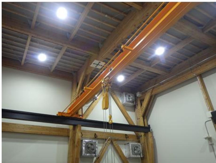
写2-10 クレーン桁据付状況
