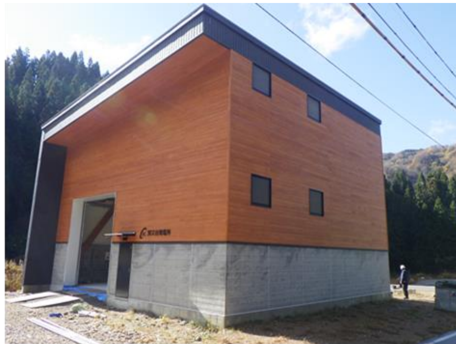
写2-11 外観（上流側）
