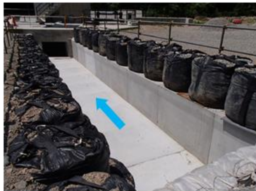
写2-15 仮排水路（拡大）
